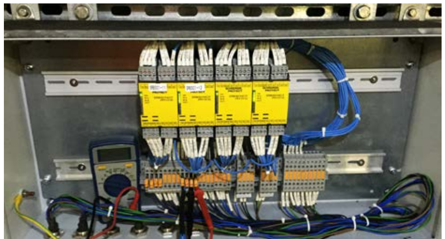
El relé de seguridad utilizado es el SRB 301HC/T, que se fabrica en la planta de Wettenberg de Schmersal, en Alemania.
