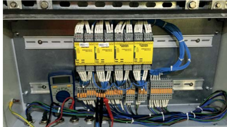
Als Sicherheitsrelaisbaustein kommt der SRB 301HC/T zum Einsatz, der im Werk Wettenberg von Schmersal in Deutschland produziert wird.
